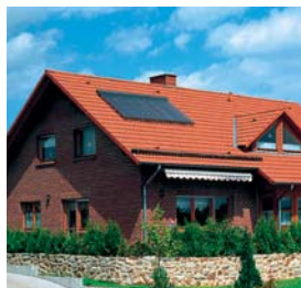
Vitosol 300-T zamontowany na dachu domu
