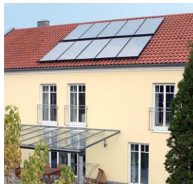
Vitosol 200-F na dachu budynku dwurodzinnego
